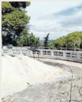
I lavori sulla Scala Santa
